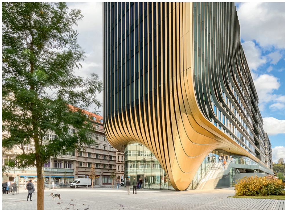
Masaryčka, Praha 1 ■ Developer: Penta Real Estate ■ Nová dominanta centra Prahy splňuje nejvyšší parametry udržitelnosti v souladu s certifikací LEED Platinum (tj. nejvyšší možný stupeň) ■ Technický facility management: Rilancio
