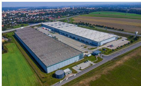
PEC Ostrava ▪ Technický facility management: Rilancio Rilancio spravuje aktuálně více než 664 000 m 2 průmyslových a distribučních prostor
